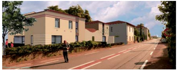
▲ 9 logements à Anneyron
