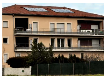
Installation de panneaux solaires à Saint-Michel-sur-Savasse
