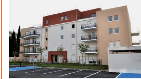
▲ Terrasses du Vercors 49 logements
