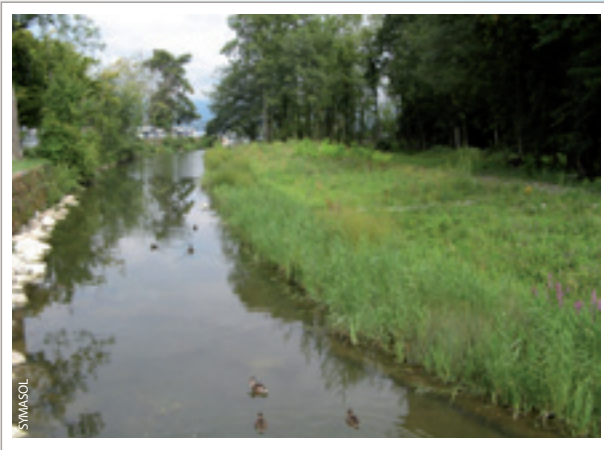
Situation après travaux
